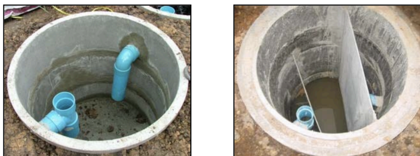
Figure 31. Septic Tank without Partition Wall and with Partition Wall (คู่มือการจัดการน้ำเสียสำหรับบ้านเรือน, 2020)
