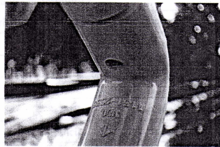
ภาพที่ 23 ด้านล่างของท่อเจาะรูเพื่อป้องกันการเกิดกา ลักน้ำ
